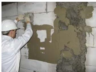
3. Нанесение **Vaumit Artoplast** зубчатым шпателем.
