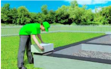
3. Первый ряд блоков укладывается на раствор
