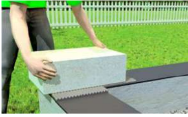
3. Первый ряд блоков укладывается на раствор
