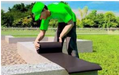
1. Выполняется горизонтальная гидроизоляция
