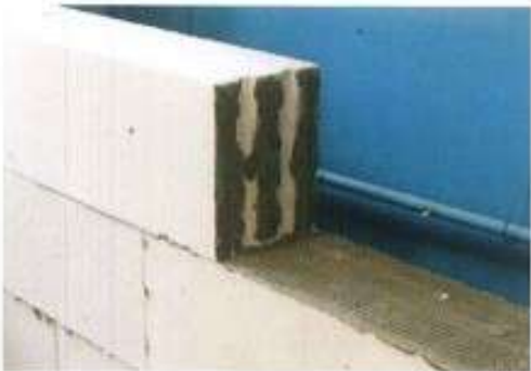
Фото конструкции стены №2
