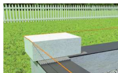
5. Натягивается шнур между угловыми блоками
