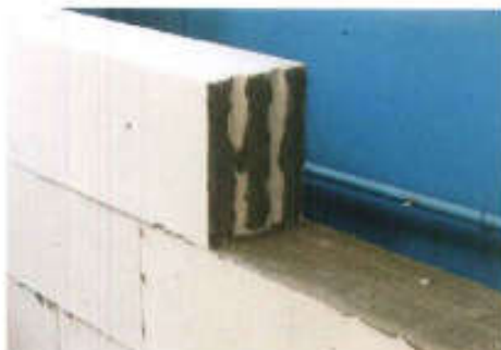
Фото конструкции стены №2
