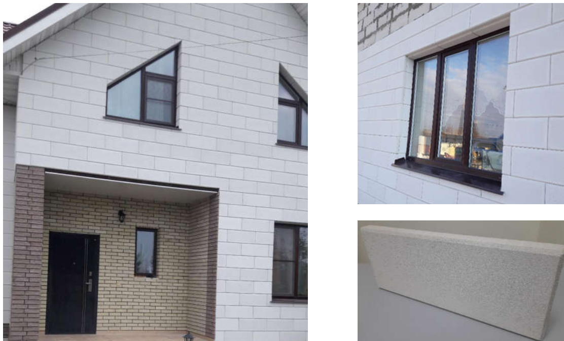
Рис.1 Кладка блоков с фаской и облицовка фасада плиткой из АГБ с фаской (5 см D400)
